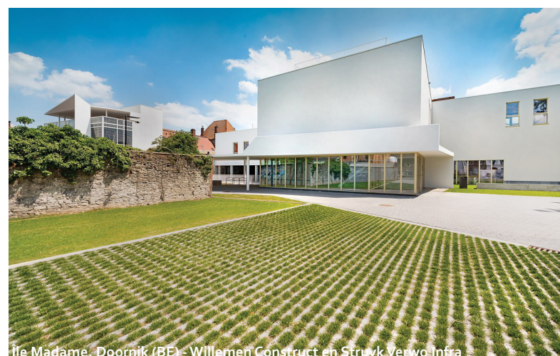
Ile Madame, Doornik (BE) - Willemen Construct en Struyk Verwo Infra
