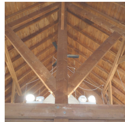
Figuur 161 nieuwe pastorie: originele dakstructuur
