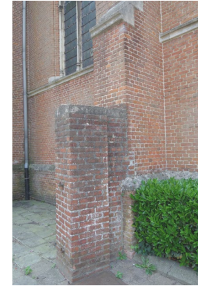
Figuur 222 aansluiting lage muur met steunbeer kerk
