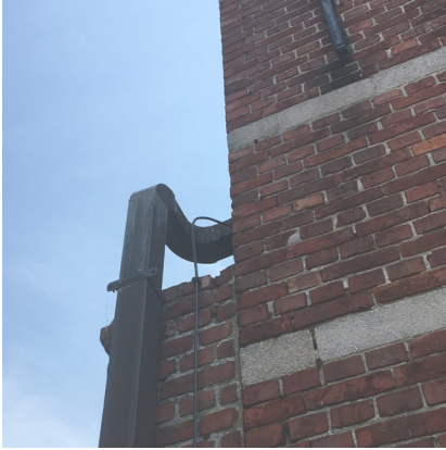
Figuur 92 detail: bocht in regenwaterafvoer
