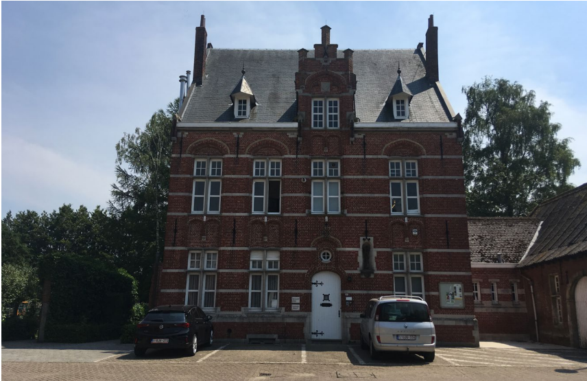
Figuur 210 exterieur voor- en achtergevel (OMGEVING, 2018)
