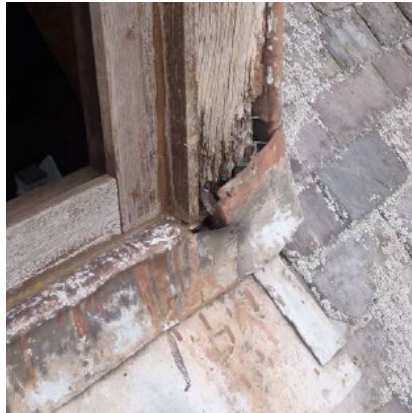
Figuur 39 slechte aansluitingen
