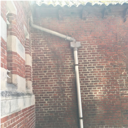
Figuur 93 oude pastorie: PVC regenwaterafvoer
