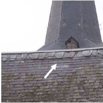
Figuur 144 bliksemafleiding
