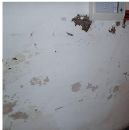
Figuur 119 toren [1] - gelijkvloers: optrekkend vocht
