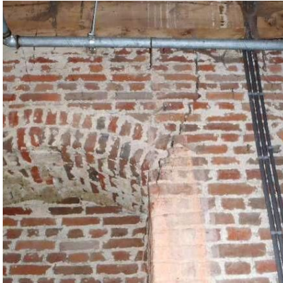
Figuur 103 toren [1] - zuid: scheuren en anker
