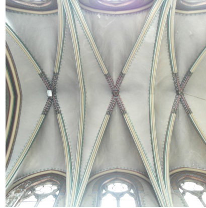
Figuur 128 profilering van de gewelfribben
