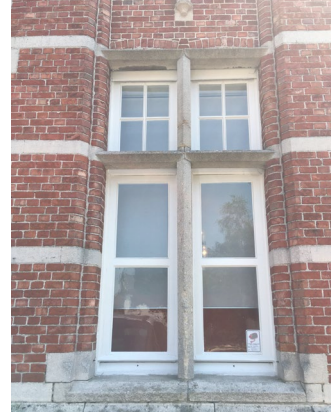
Figuur 88 ramen; voorgevel nieuwe pastorie
