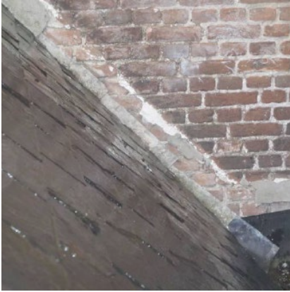
Figuur 36 koud aangewerkt lood
