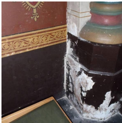
Figuur 117 vleugel [8]: optrekkend vocht
