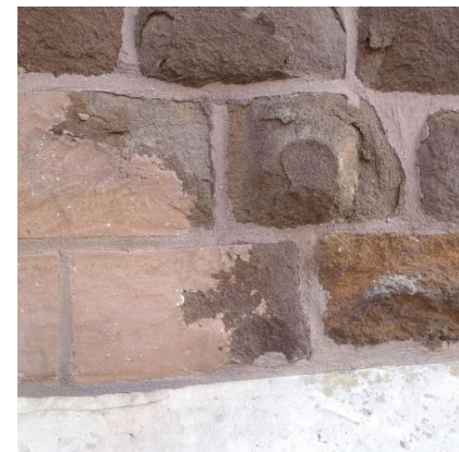
Figuur 51 plaatselijk sterk verweerd ijzerzandsteen
