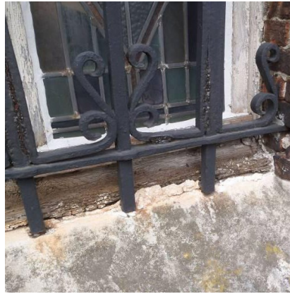
Figuur 70 buitenschilderwerken schrijnwerk
