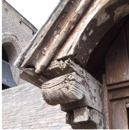
Figuur 38 verweerd houtwerk
