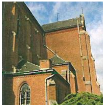
Figuur 49 wirwar van regenwaterafvoeren
