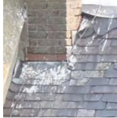
Figuur 40 dak [4]: loskomende loodslabben
