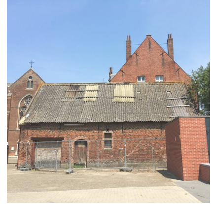
Figuur 98 achtergevel oude pastorie
