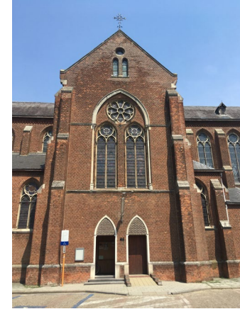
Figuur 232 zuidelijke vleugel kerkgebouw
