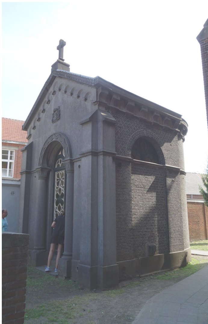
Figuur 76 rechthoekige grafkapel met cirkelvormige sluiting met hardstenen voorgevel
