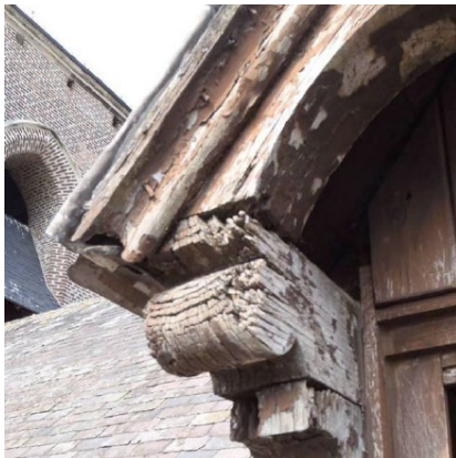
Figuur 69 buitenschilderwerken dakkapel
