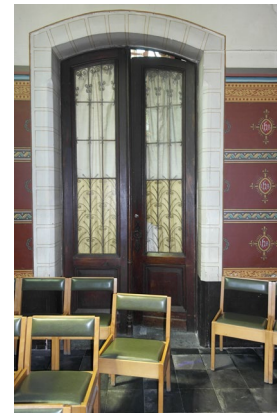
Figuur 129 dubbele binnendeuren (zijkapel); met steenimitatie schildering
