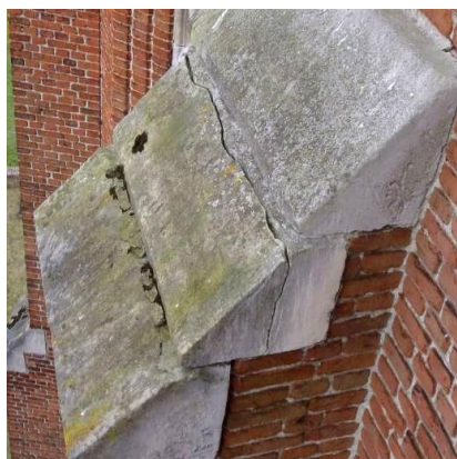
Figuur 55 gebroken afzaat
