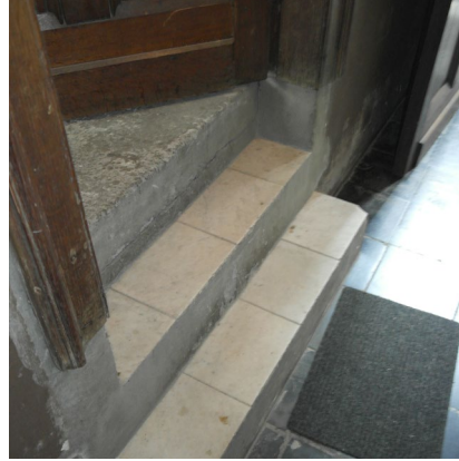
Figuur 126 60 cm verhoogde vloer door realisatie stookkelder
