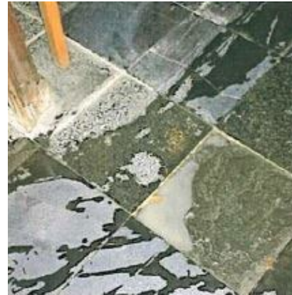
Figuur 120 degeneratie van sommige vloertegels
