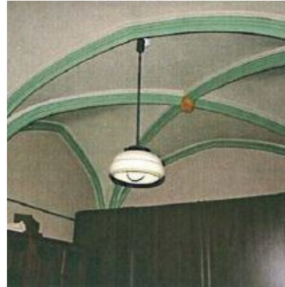
Figuur 106 plafondgewelf sacristie: niet originele kleuren
