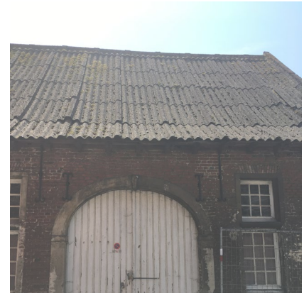
Figuur 99 oude pastorie: (asbest) golfplaten detail buitenschrijnwerk
