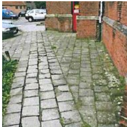
Figuur 71 onaangepaste, gevaarlijke en verzakte buitenverhardingen
