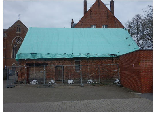
Afdekking van het dak in afwachting van de restauratie.
