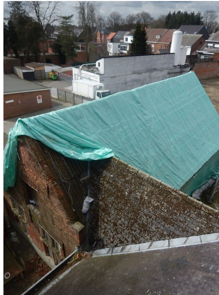
Afdekking van het dak in afwachting van de restauratie.
