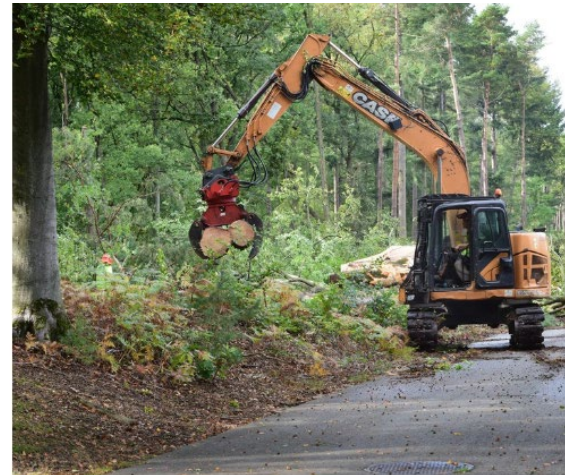
De kap van een hele beukenlaan in de Herentals Bornstraat is begonnen. De bomen zijn v Natuur en Bos niet meer in goede staat en zouden een veiligheidsrisico vormen.
